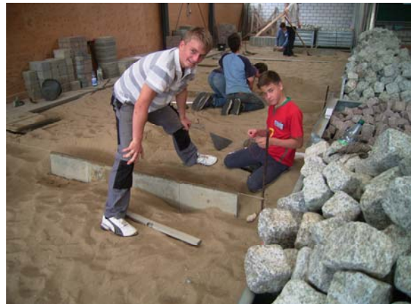
Nikolas und Maurice (Straßenbau)
